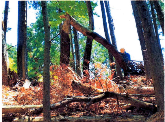
急斜面での土留めづくり 10・20
