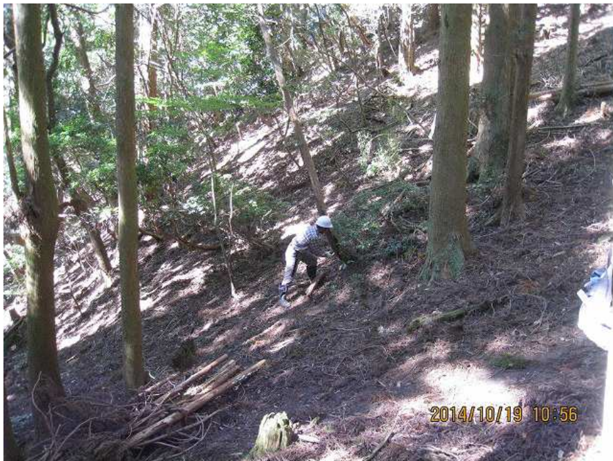
④ 遠景 作業中
