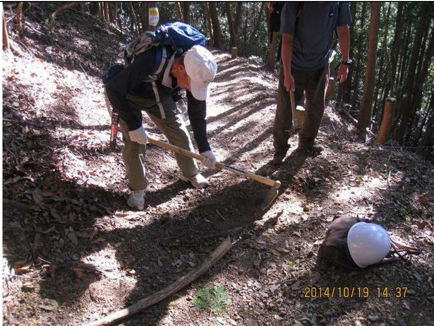
⑩ 水切り溝整備
