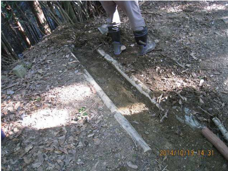
⑪ 水切り溝整備作業後
