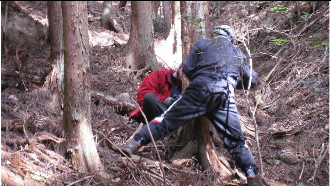
⑦ 近景 作業中
