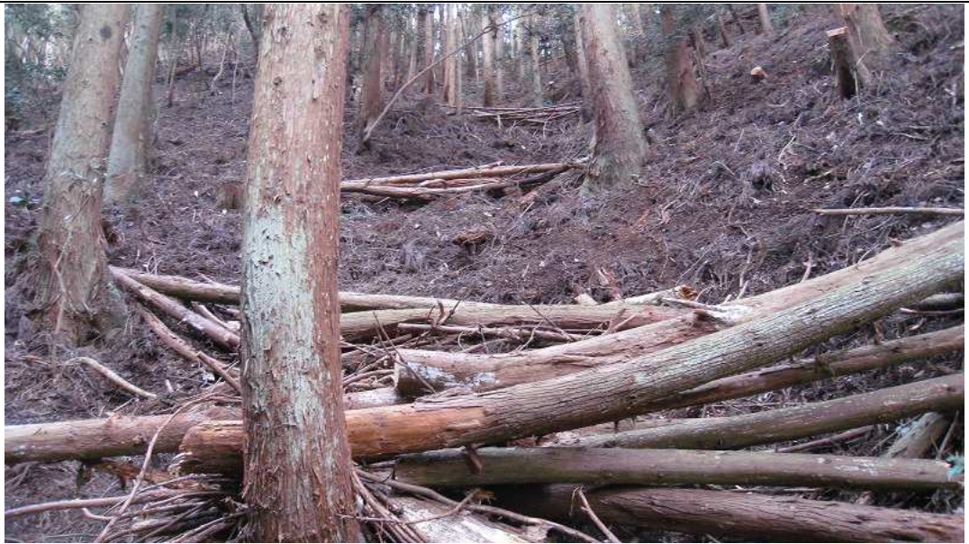
⑭ 伐倒木で土留めを作る
