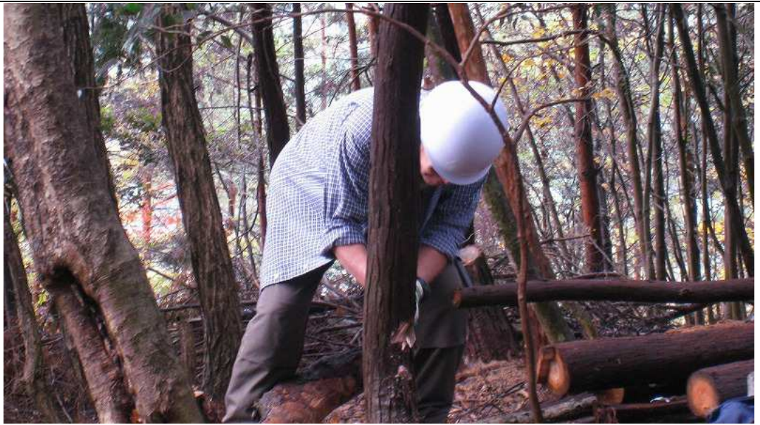
⑨ 枯損木除伐中
