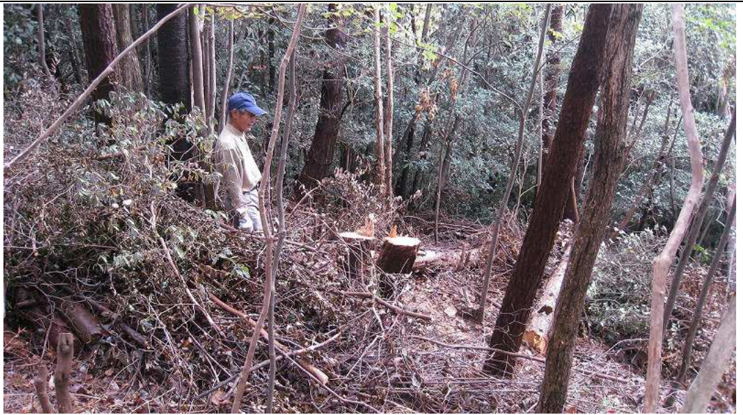
④ 遠景 作業後
