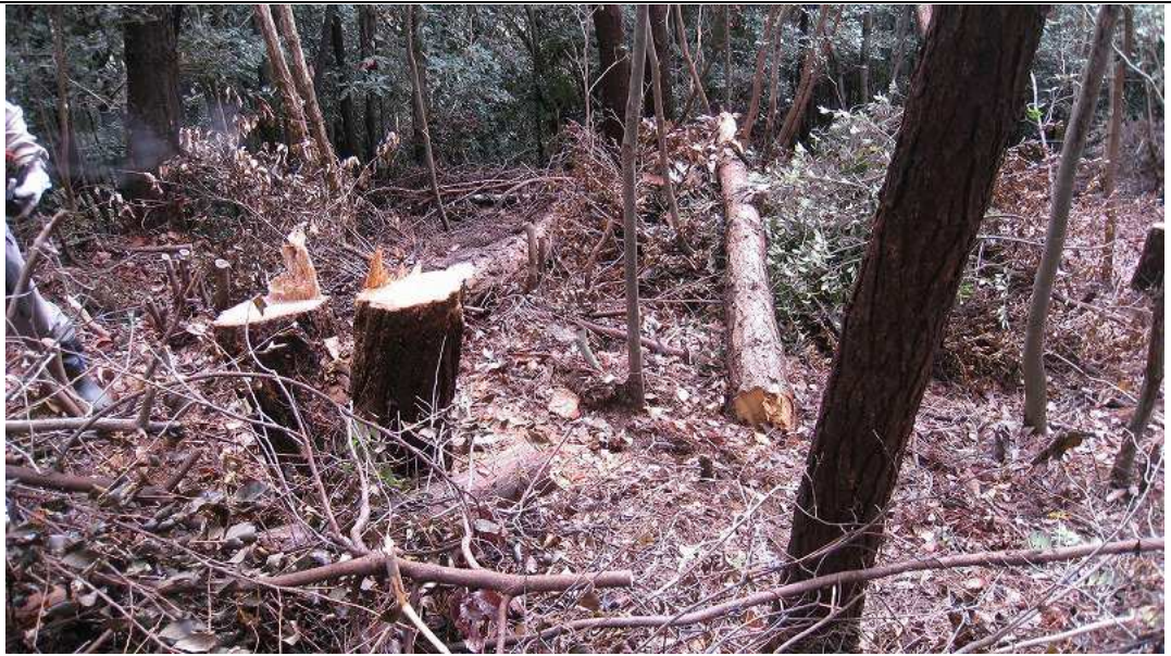
⑦ 近景 作業後
