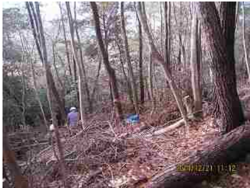
③ 遠景 作業前
