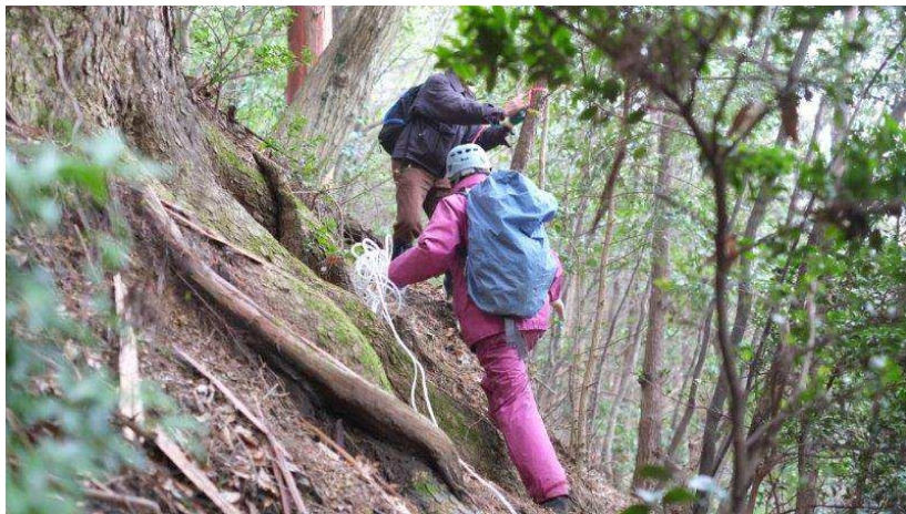
④ 急傾斜地が多いので、区画確定作業もひと苦労
