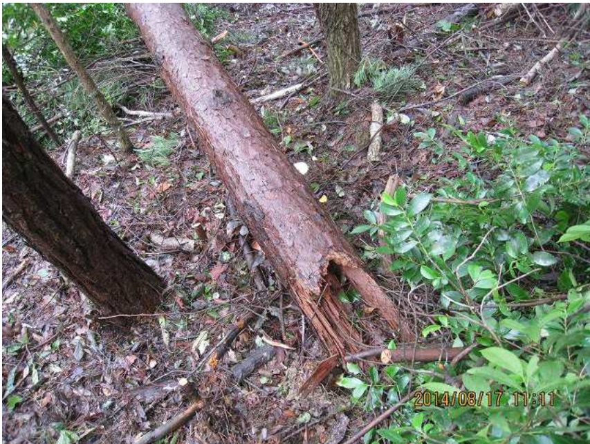
⑤ 倒木整理 作業前 近景
