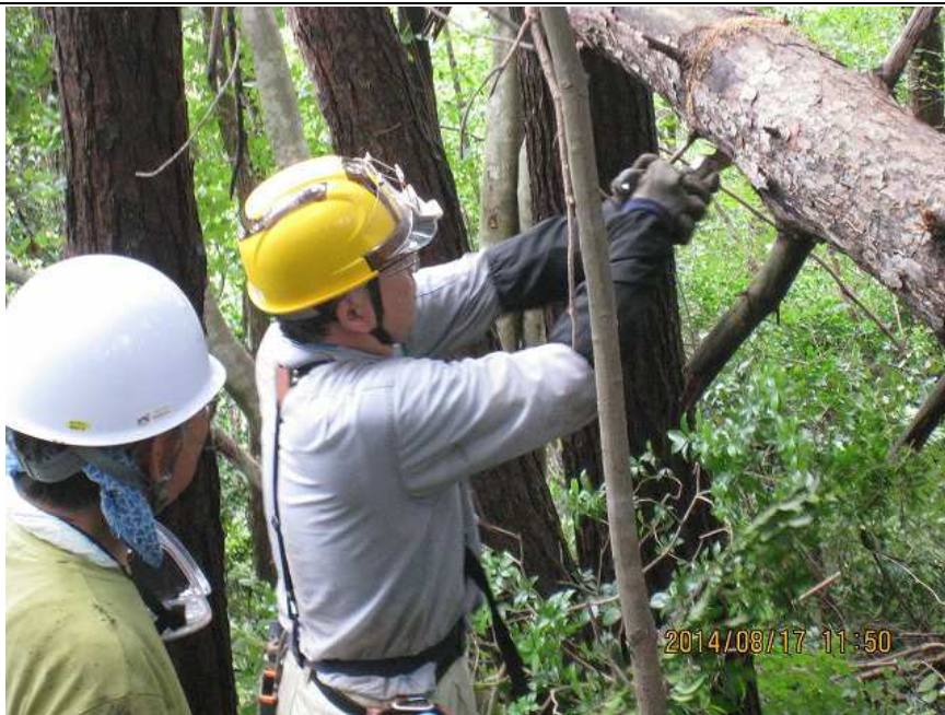
⑥ 倒木整理 作業中 近景
