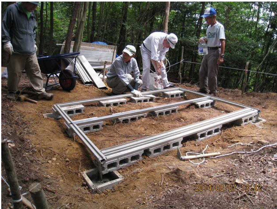
⑩ 物置設置作業 1 水準器で水平を確認しつつ土台作り
