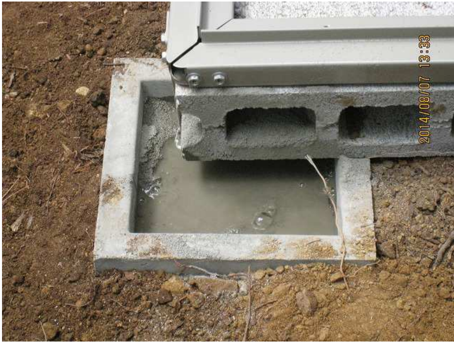
⑪ 物置設置作業 2 四隅は 25cm 立方の升口をセメントで固める
