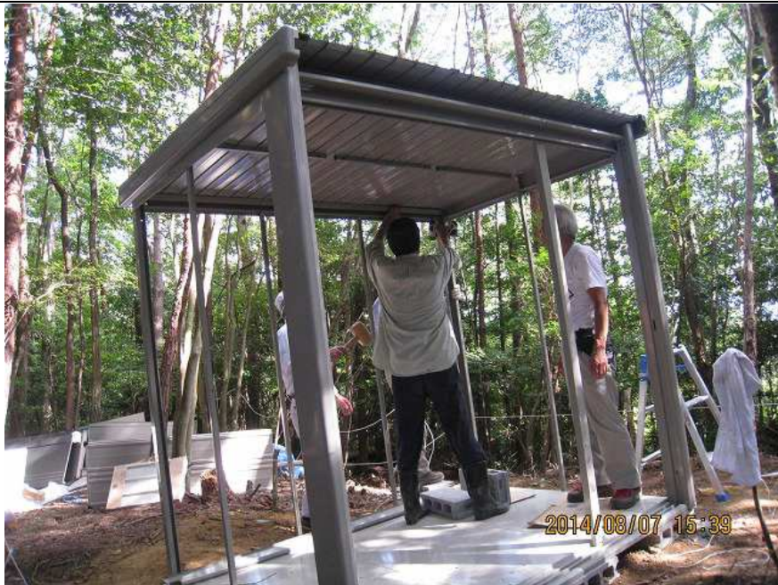
⑫ 物置設置作業 3 骨格が完成
