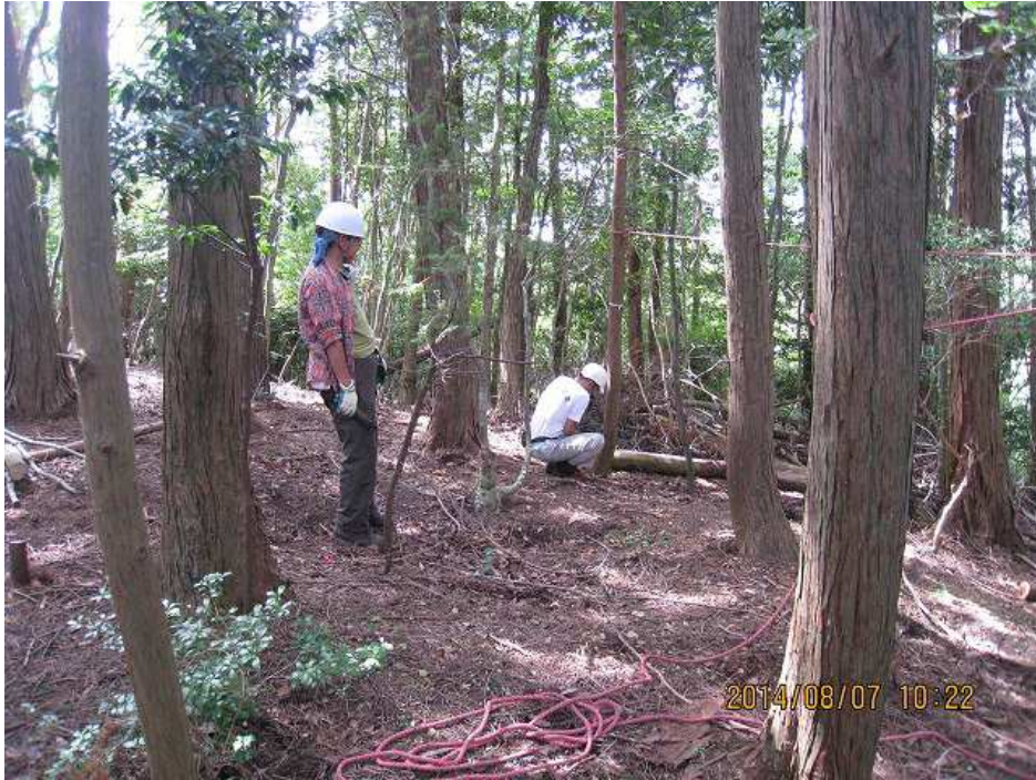
③ 枯損木除伐 作業中 遠景
