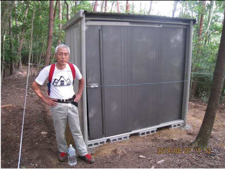
⑬ 物置設置作業 4 ようやく完成したが、扉に隙間があり次回手直しが必要
