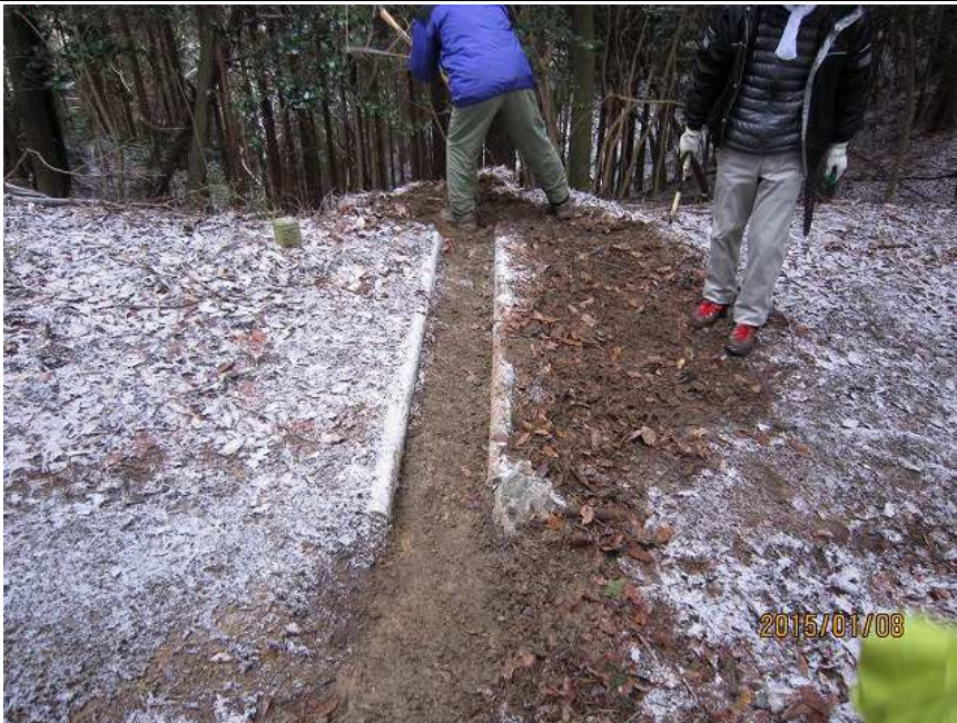
4)溝整備作業後
