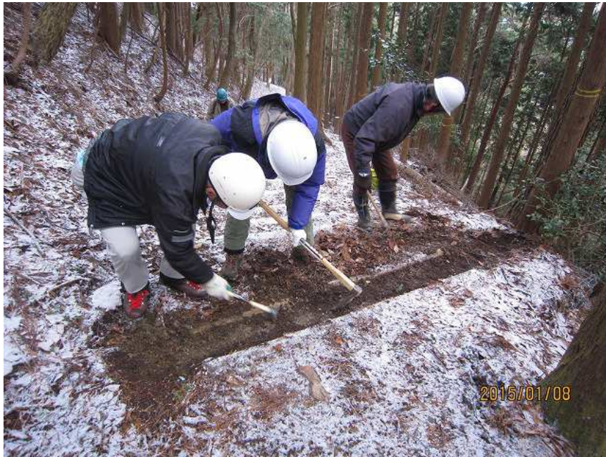
3)水切り溝の整備作業中
