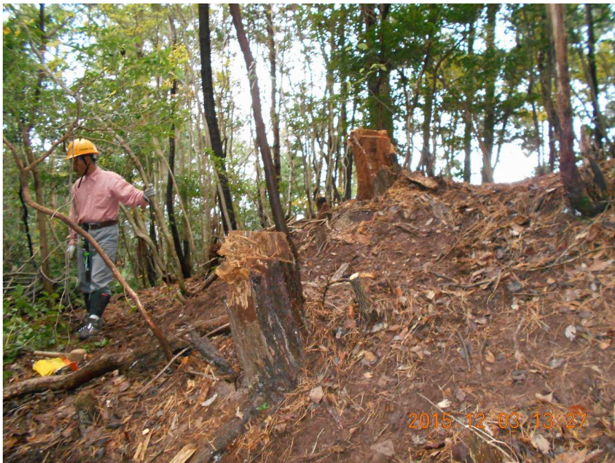
④ 明るくなった林間
