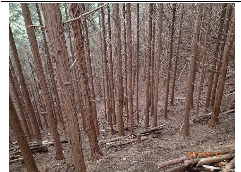
④ 伐り捨て材をまとめて、処々に土留めを作る
