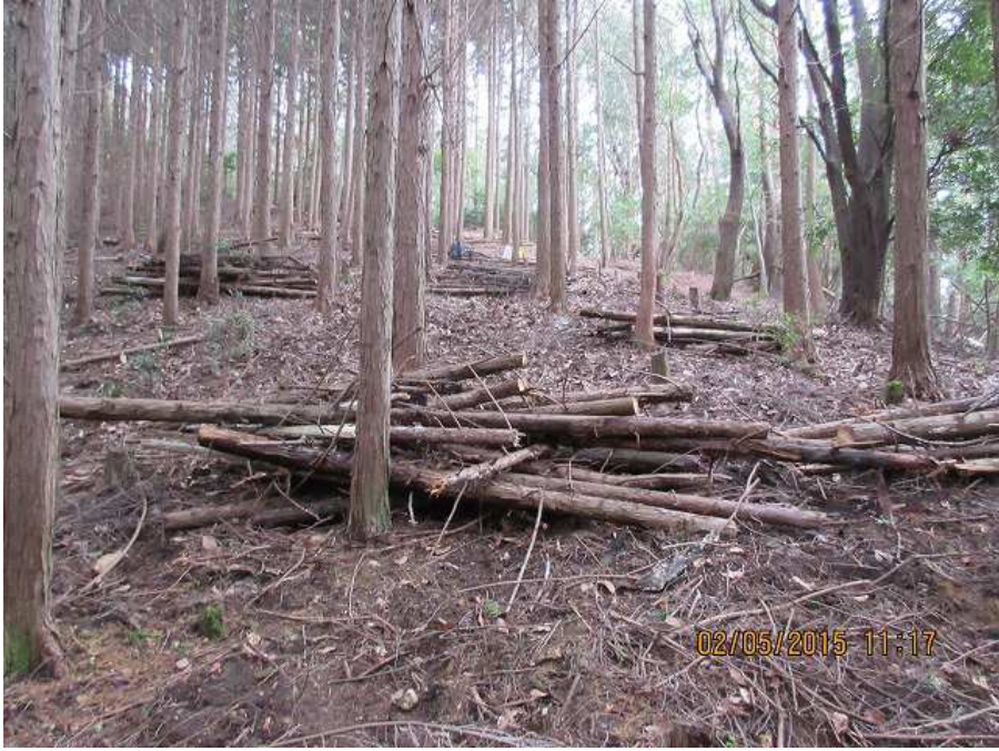
③ 土留めを作る
