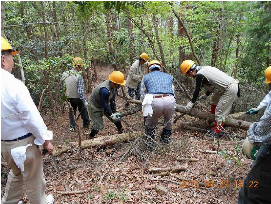
3 作業道整備 作業
