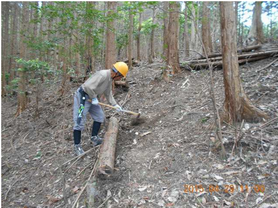
2 作業道設置 作業中
