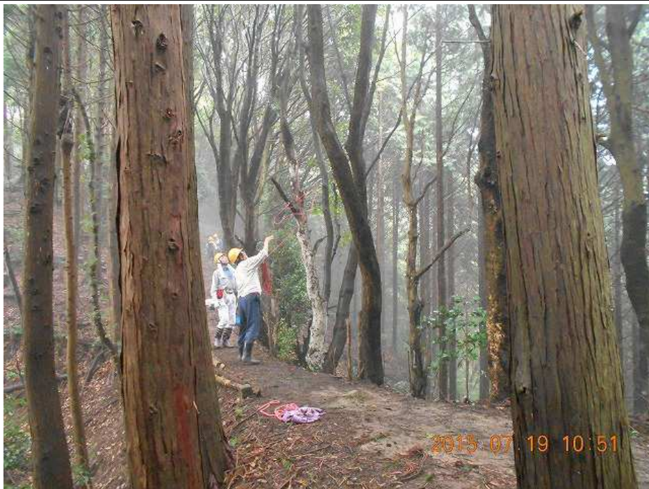
2) 遠景 作業前 自然歩道脇の危険木の伐採作業
