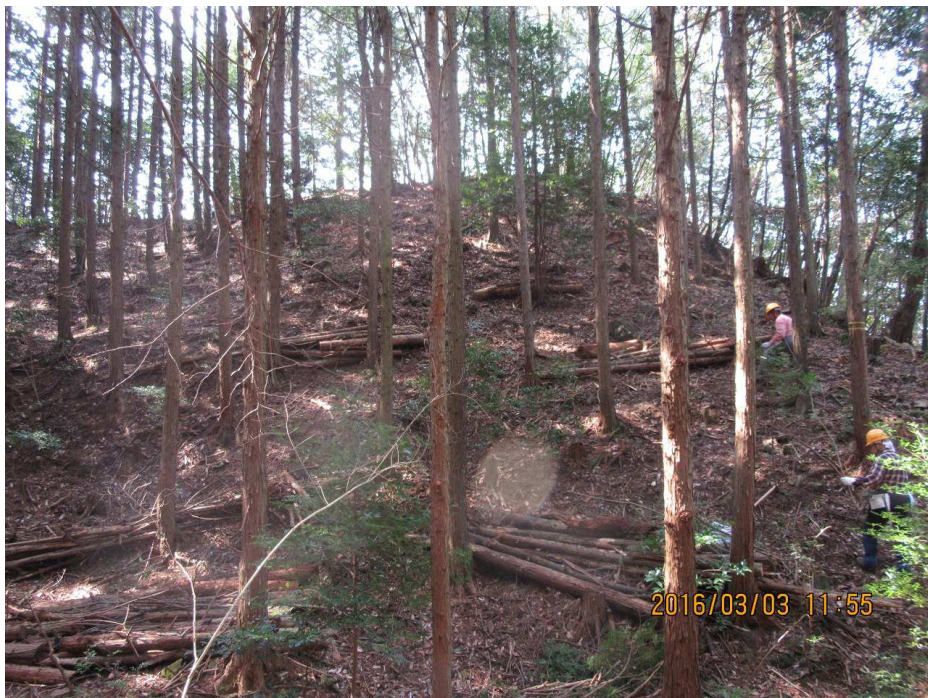
⑤ 林床整備作業後（伐倒木を横に揃えて土留めを作る）
