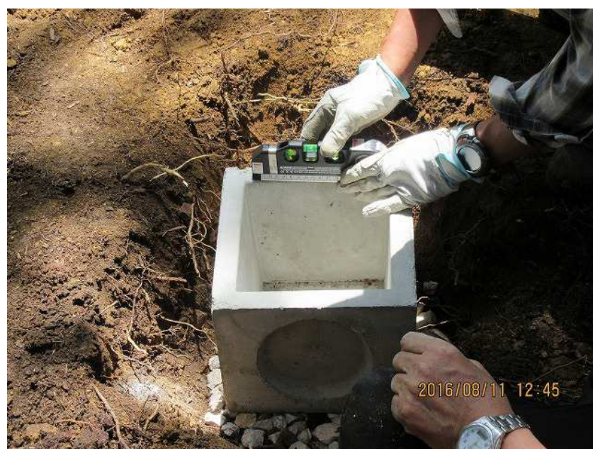
7. 升口を埋め込み、水準器で升口の上面の水平度を確認する
