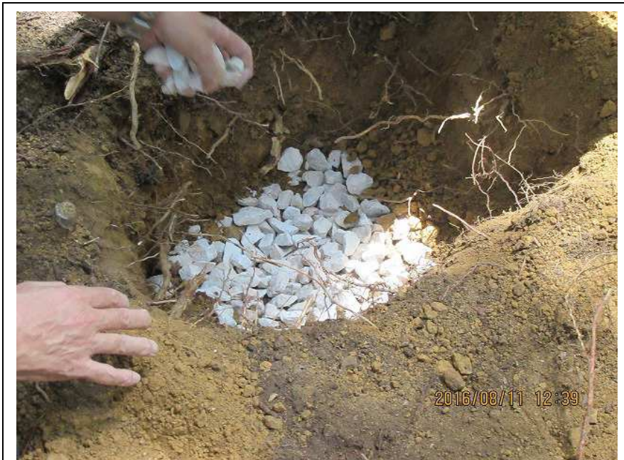
4 . 穴の底に碎石（バラスト）を敷き詰める
