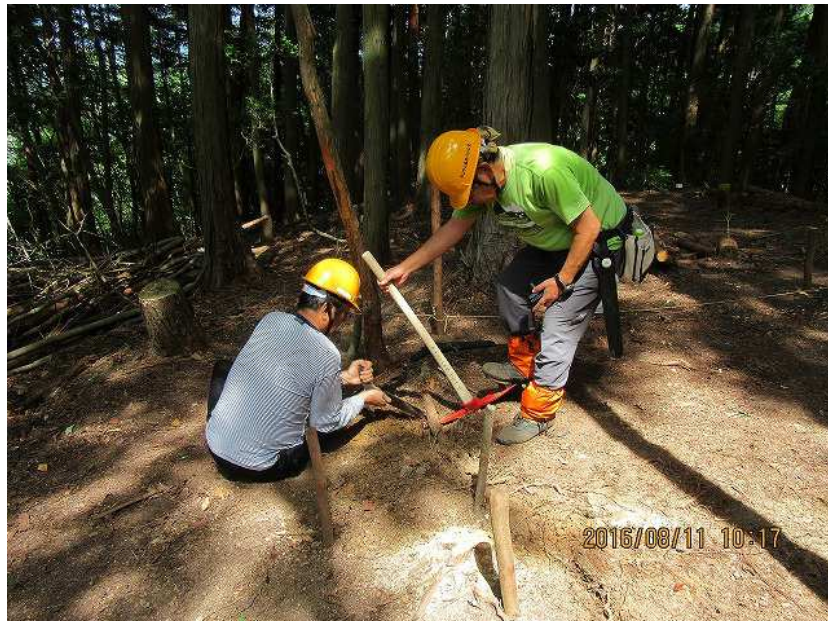
3 . 四 隅 に 、 2 5 c m 四 方 の 升 口 埋 め 込 み 用 の 穴 を 掘 る
