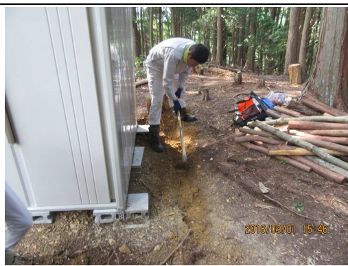
⑪ 物置周囲の溝掘り
