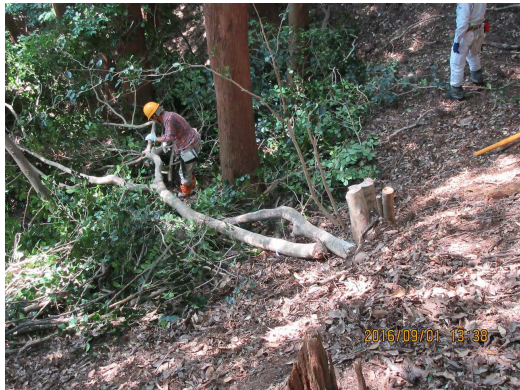
⑦ 伐木後の処理
