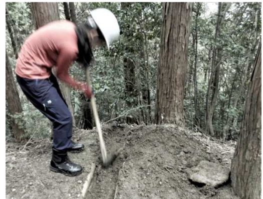
【旧道の作業-大きな石が埋まった溝を掘り返す】
