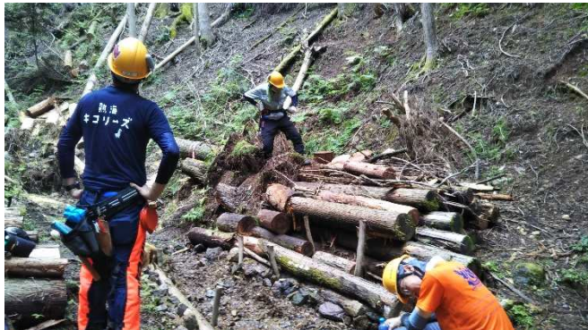
【斜面での土留めづくりは用材運搬に一苦勞】
