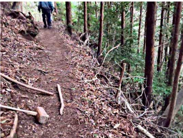
【補強材が落ちてしまった歩道】
