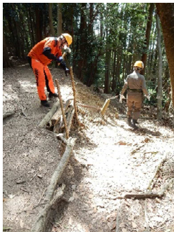
【路肩に杭打ち歩道の補強】
