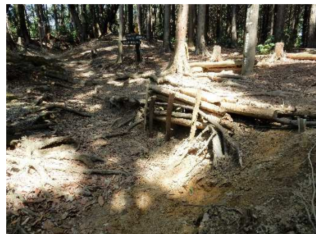
【左の施工後(右が旧道)】
