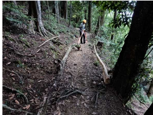
【倒木を路肩補強箇所に運ぶ】
