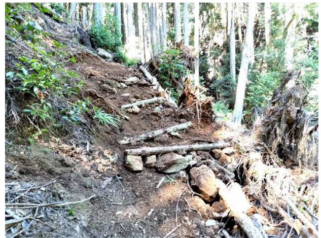
【石と倒木で階段状の巻道概成】
