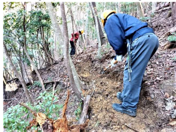
【山腹を削って足元を均す】
