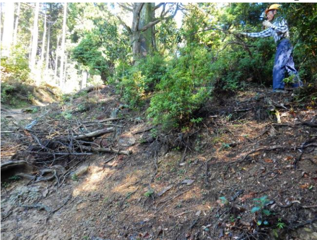
【自然歩道東側の倒木処理(国有林からの倒木)】
