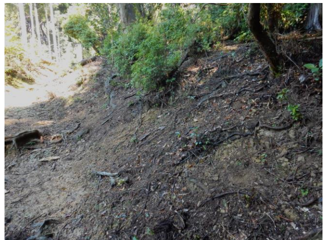
【整備済みの歩道(処理木は国有林側に棚積み)】
