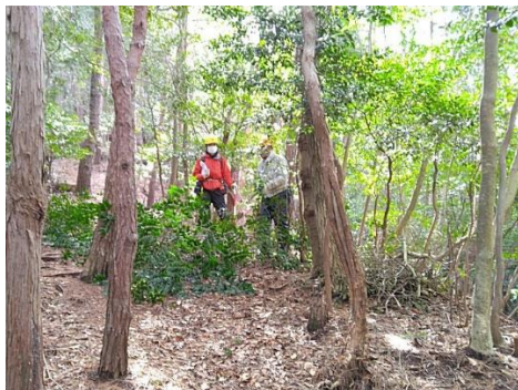
<作業前 上手組の作業地例>
