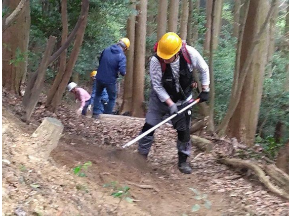
<狭まった道を均して広げる>
