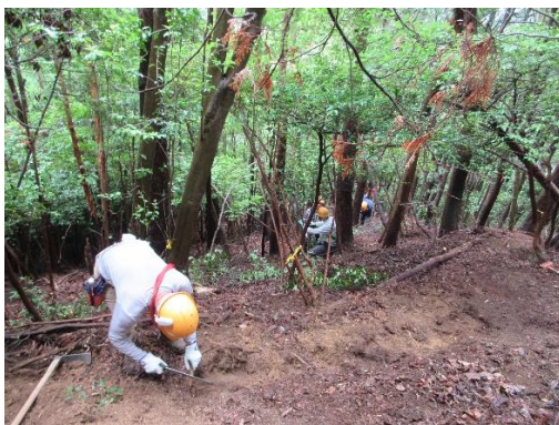
<作業地を上から俯瞰する>
