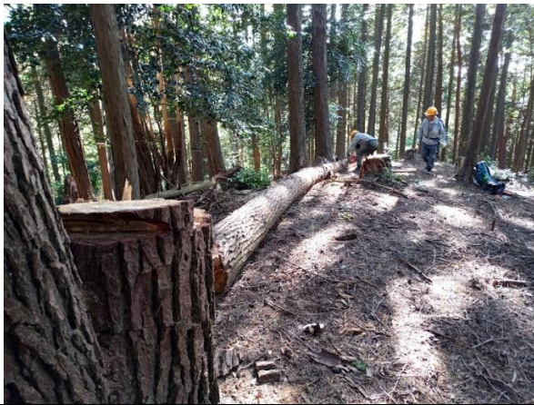
<拡幅し、土を谷側に寄せた作業道>
