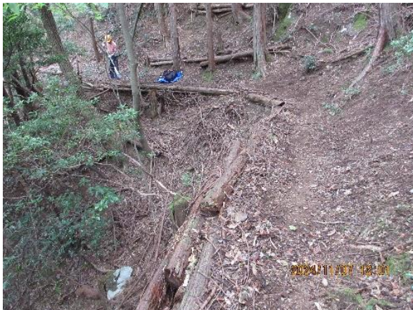
<拡幅し、土を谷側に寄せた作業道>
