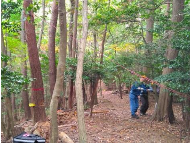
<先ずロープ架け。安全な伐倒を>
