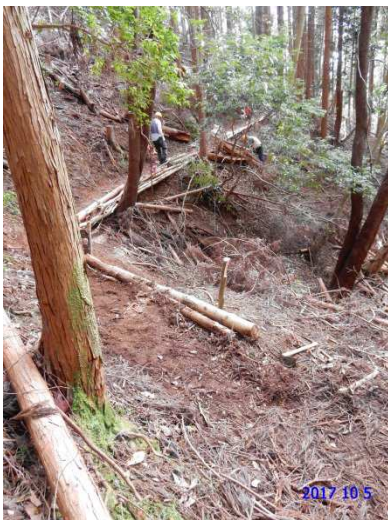
【安全作業で部分開通】
