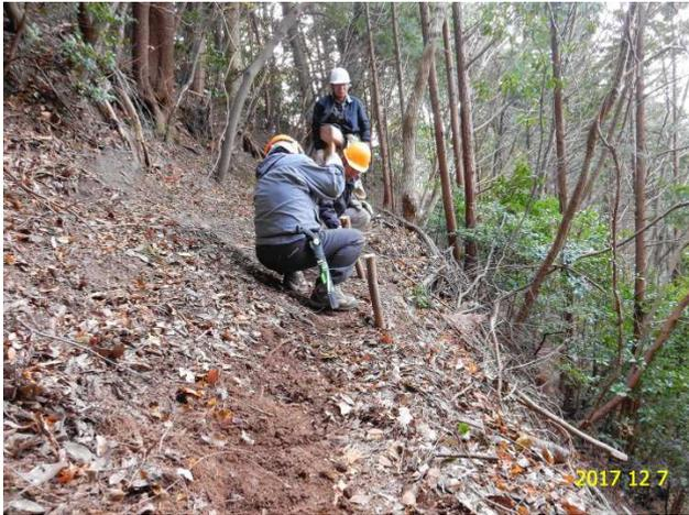
【里道の補修-山腹を削って拡幅】
