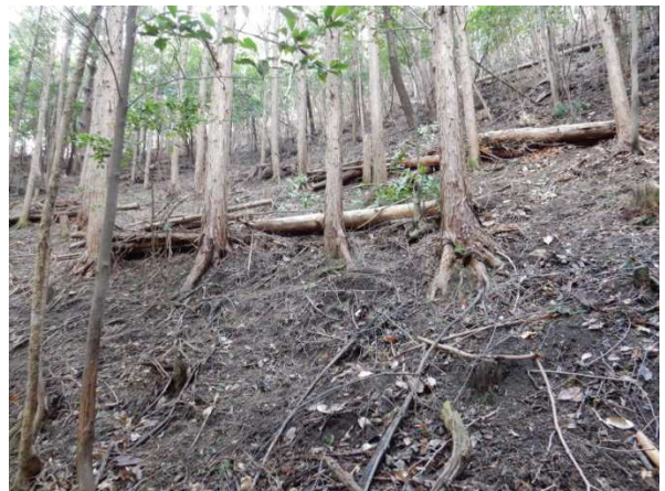
整備後の谷—残置木を切り揃え等高線沿いに積む
