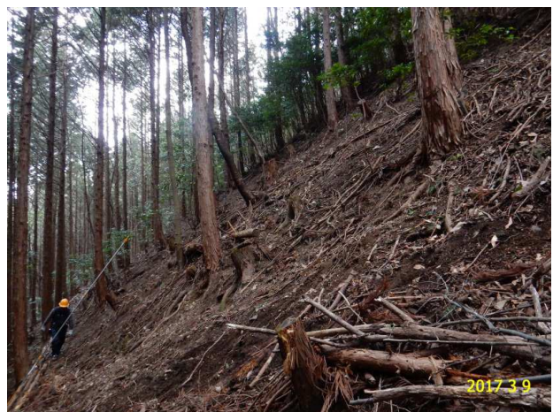
整備後-斜面の残置木は玉切りし等高線沿いに棚積み
