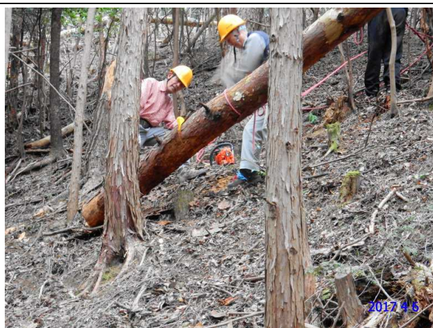
チェーンソーで根元部分を切り楔を入れて切り落とす
