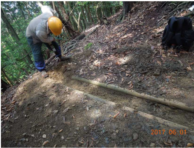
水切り溝の補修
