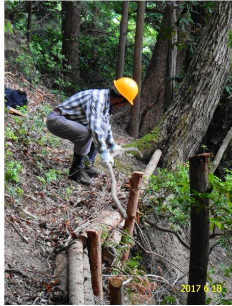
路肩に杭打ちし残材で強化
