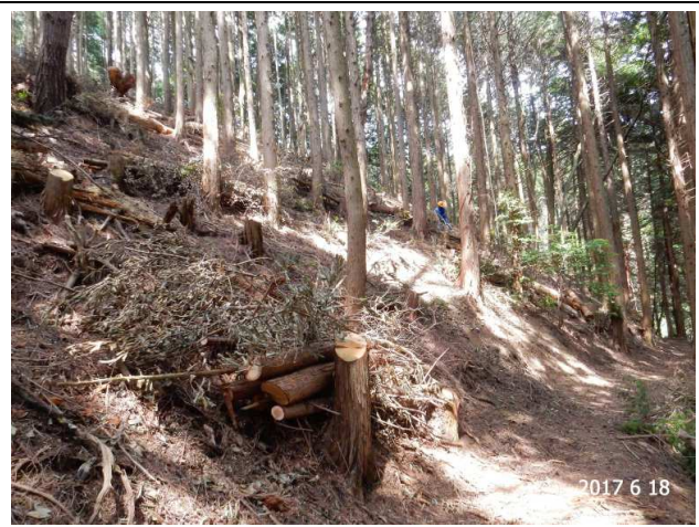
整備後の東面
