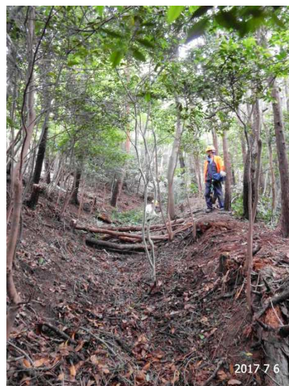
同上 整備完了
