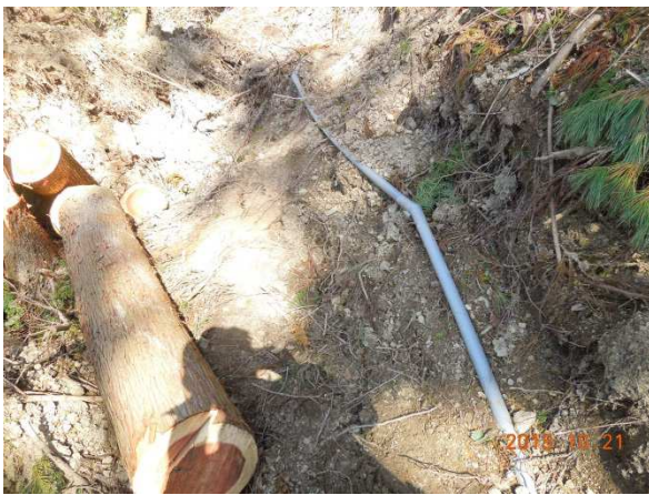
⑮ : 水源からの引水管(仮復旧済み)
