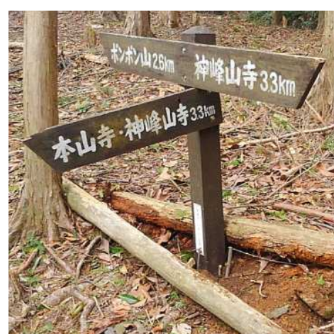
⑱：道標の修復・根元を補強し埋め戻す
