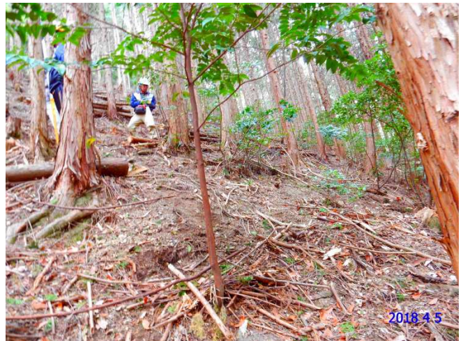
【⑦足場を注意しながら懸命の作業が続く】
