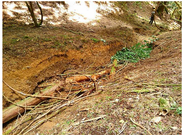
【廊下に処理木を置き連ねる】一河床の洗堀を抑止 (今後、必要に応じ下流にも木柵増置予定)
