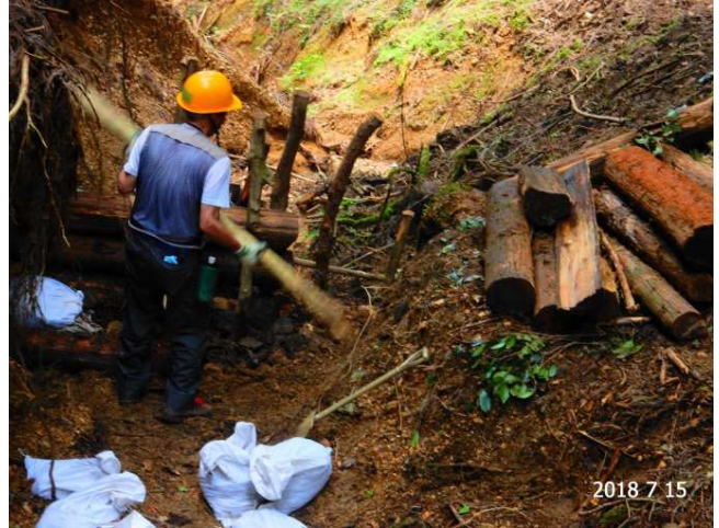
【7/15 木柵改修】一水が通るよう右岸を空ける
