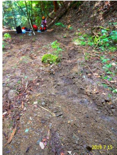
【7/15 流路拡幅】一土嚢の土採りを兼ねる
