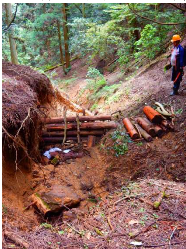
【7/12 左岸側の洗堀が進んだ木柵】
