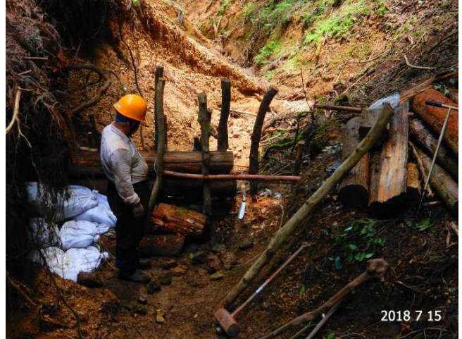
【7/15 木柵改修】一完成状態、左岸は土嚢で補強
