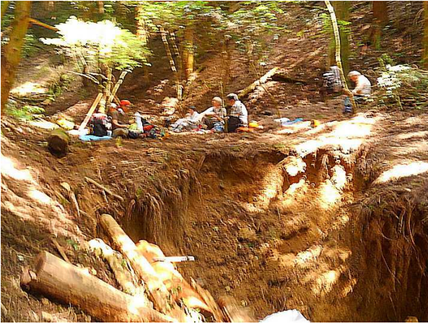
【弁当 Time】一木柵手前の崩落は 2m 以上
