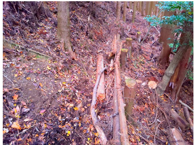
【路肩補強材を追加した作業道】
