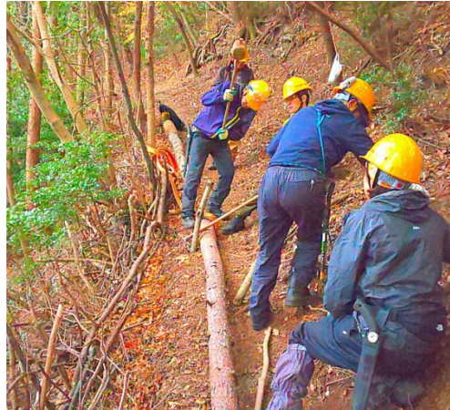
【土留めで土の流出を防ぐーカケヤの活躍】
