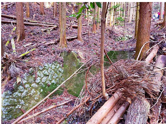
⑪苔生した砂防堰堤
