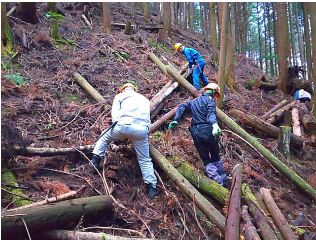
【木を運んで土留めの棚を積む】
