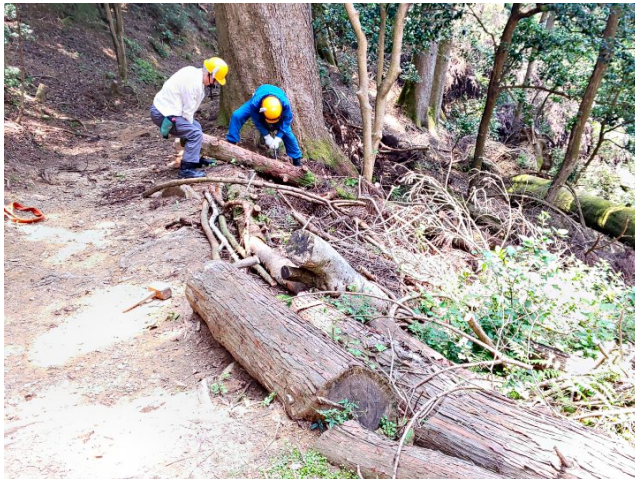
⑪ 歩道に引き上げて路肩の補強材に
