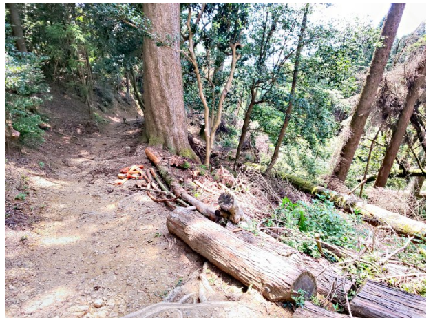
⑫ 路肩も補強し、この日の整備完了
