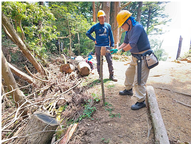
⑦ 処理木を利用し路肩を補強、杭打ち中
