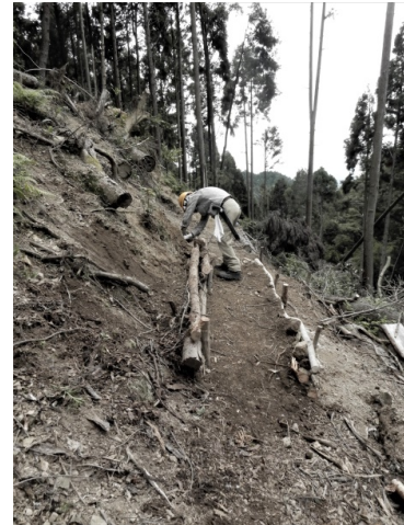
【給水管を埋め戻し、覆った上に道の新設】
