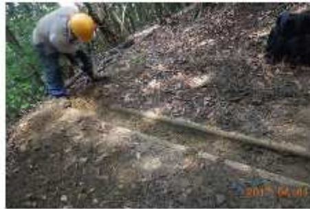
水切り溝の補修 2017年6月
